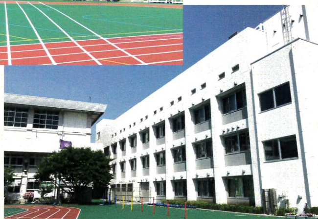
プール棟 2023年3月完成
